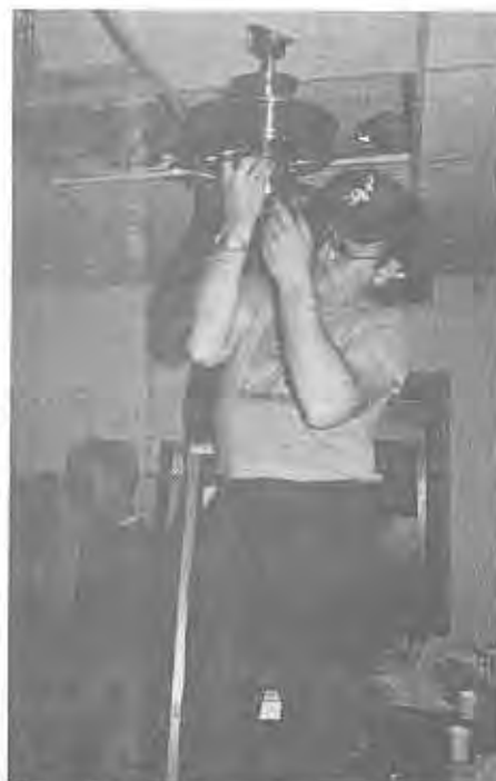
TSGT. WAYNE SMITH Installs ceiling fan
